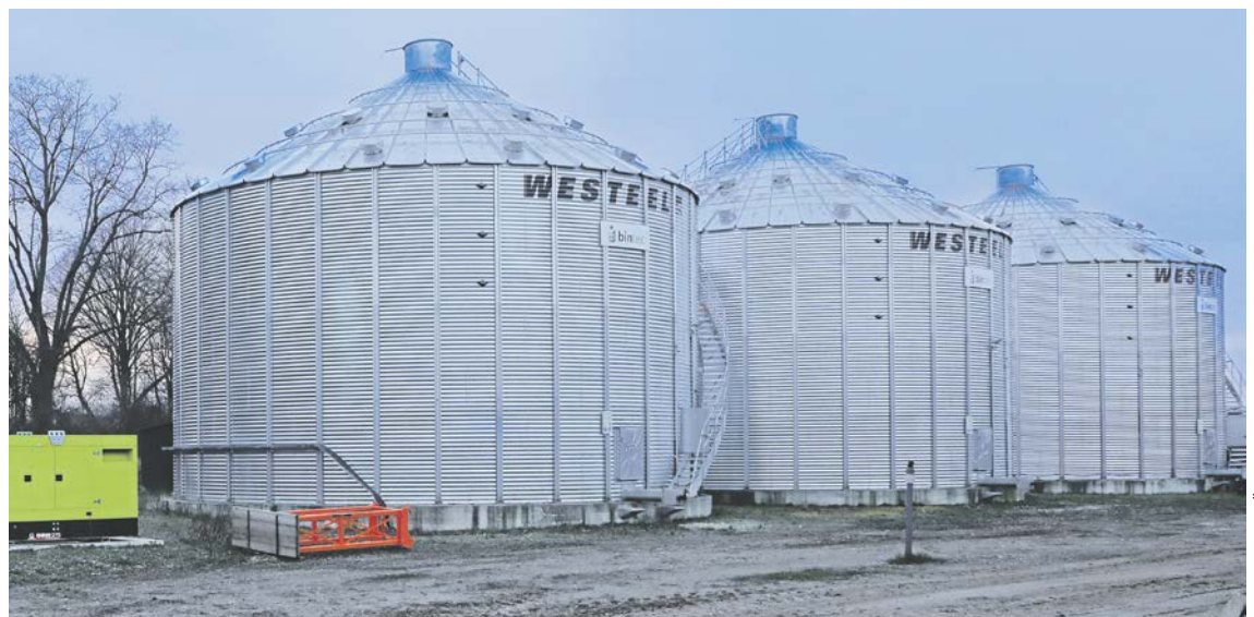
Die neuen Silos mit der Möglichkeit der Belüftungstrocknung haben ihre zweite Saison fast hinter sich.
