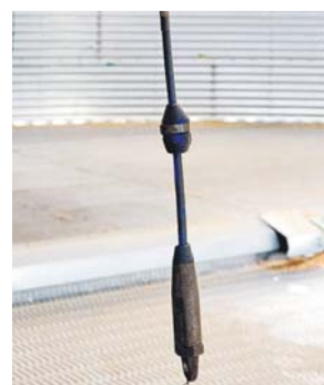
Vom Silodach herabhängende Sensoren messen an verschiedenen Punkten permanent Temperatur und Feuchtigkeit des Getreides.
