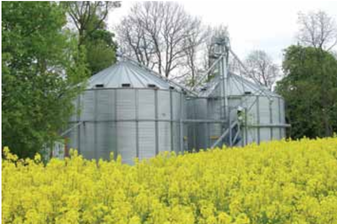
Abb. 2: Silotrockner – Zwillingsanlage kann die Trocknerleistung erheblich steigern.
