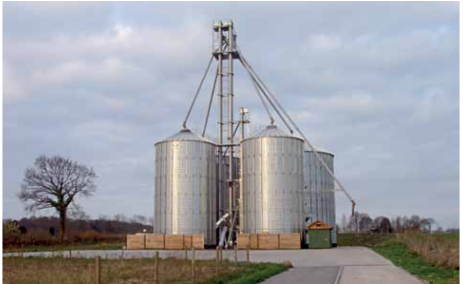
Abb. 1: Siloanlage mit Durchlauf- trockner.
