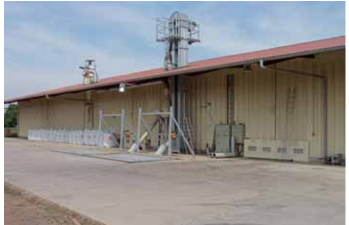
Abb. 3: Lagerbelüftungstrocknung mit seitlich angeordneter Annahme und Reinigung.
