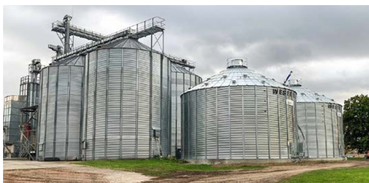
In unmittelbarer Nähe zur bestehenden Anlage wurden auf dem Betrieb Tophoff-Kaup zwei Bintec-Silos errichtet.
