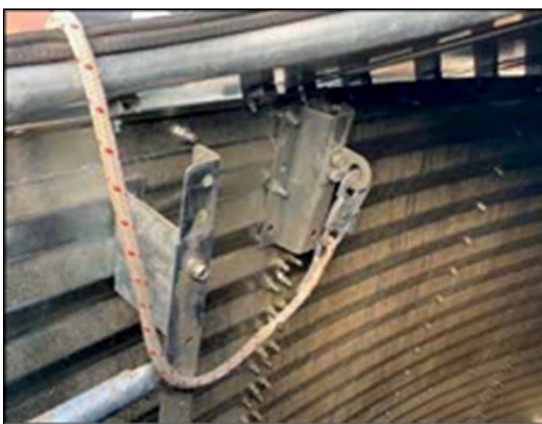
Anschlagpunkt Auffanggurt innen mit Gurt
