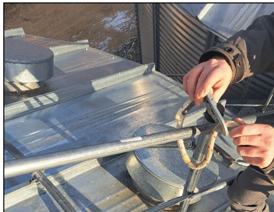
Anschlagpunkt für den Weg zum Silodach, am Geländer
